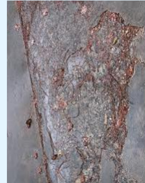
Spalling
