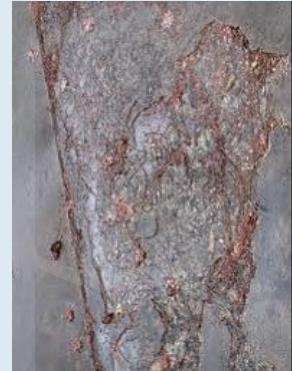
Spalling
